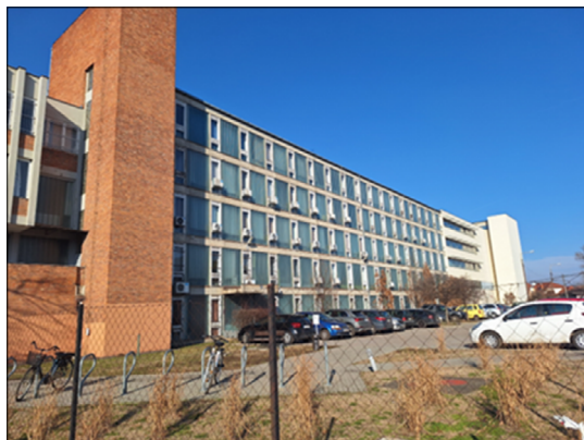
2. ábra. A Műszaki Kar keleti tájolású szárnya
