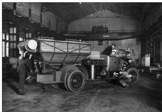
2. ábra. A kísérleti szárazoltó-berendezés gyártása [3]
