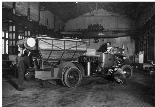
2. ábra. A kísérleti szárazoltó-berendezés gyártása [3]
