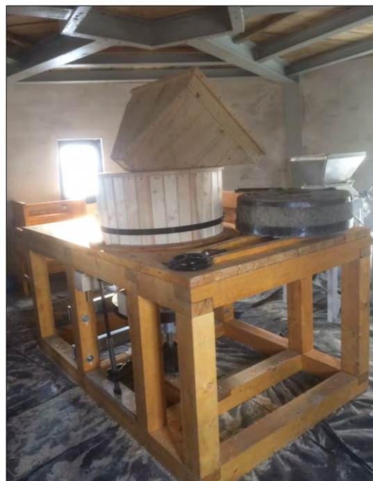
7. ábra. A szélmalom szerelés közben
