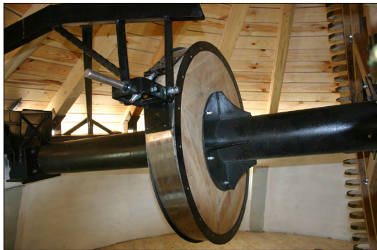
8. ábra. A szélmalom féjszerkezete
