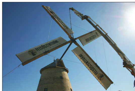
6. ábra. A szélkerék felemelése, helyretétele
