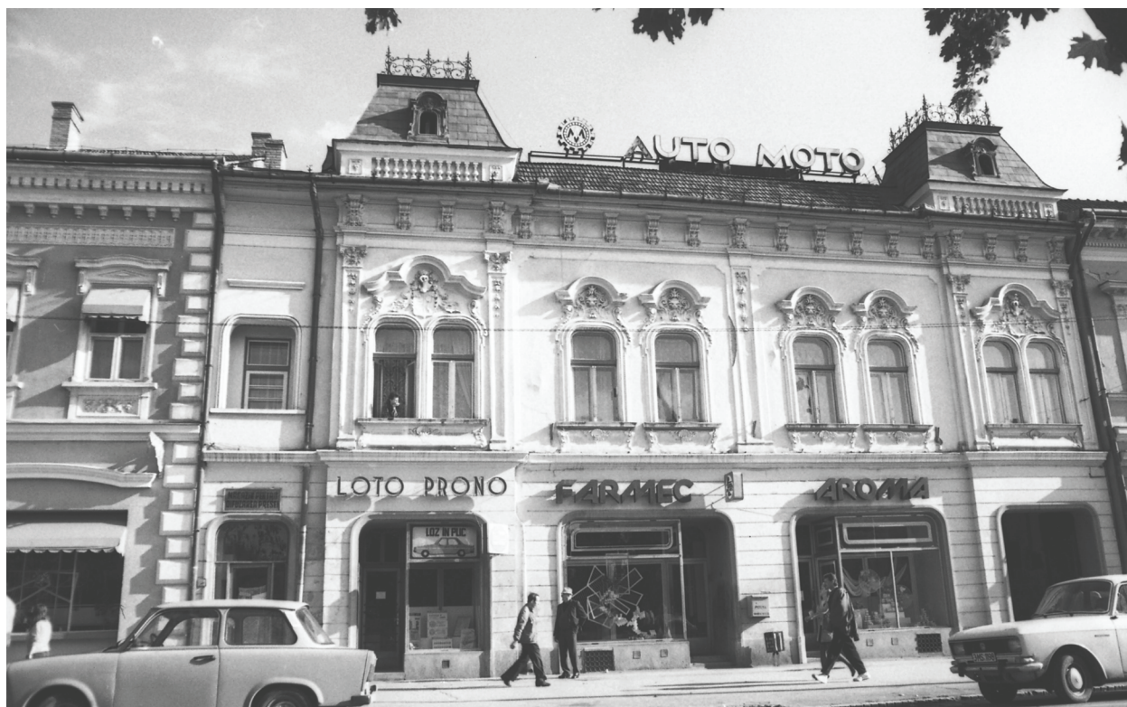
14. A ház főhomlokzata, 1990 / Main façade of the house, 1990
