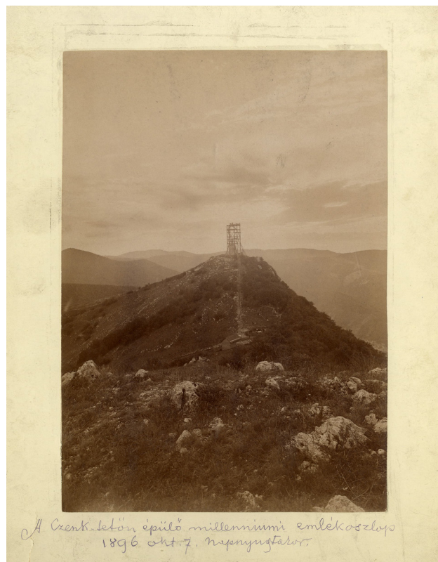
1. kép. A Cenk-tetőn épülő millenniumi emlékoszlop 1896. október 7-én (MNM Történeti Fényképtára, lsz. 654/1960 fk.) Fig. 1. The monument commemorating the Hungarian Millennium (Millennial Column) during construction on the Cenk Mountaintop, in 7 October 1896 (The Historical Photo Department of the HNM, inv. no. 654/1960 fk.)
