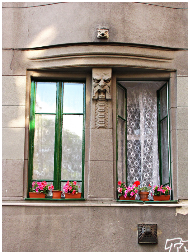
33. kép. Bérház, Üllői út 119. szám, Budapest, 1910 körül (a szerző felvétele) Fig. 33. Tenement house, 119 Üllői street, Budapest, built around 1910 (photograph by author)
