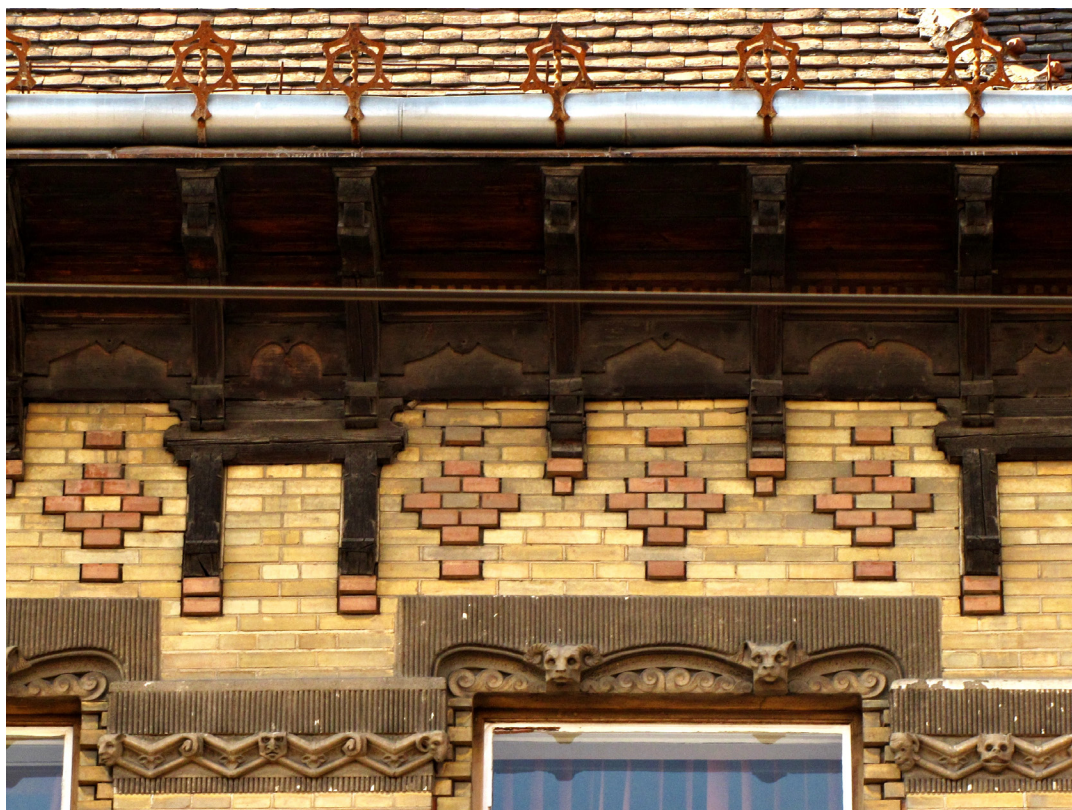
14. kép. Főhomlokzat, koronázópárkány (a szerző felvétele) Fig. 14. Main facade, cornice (photograph by the author)
