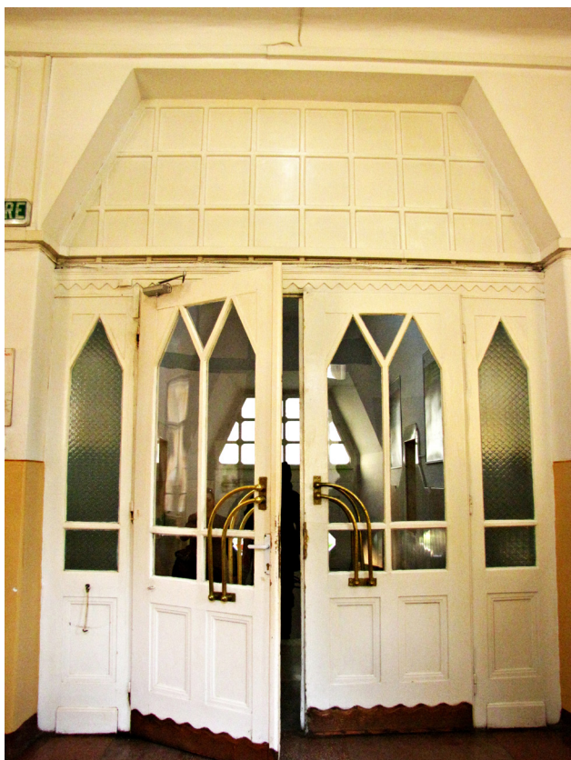
16. kép. Főbejárat, lengőajtó (a szerző felvétele) Fig. 16. Main entrance, swing-door (photograph by the author)
