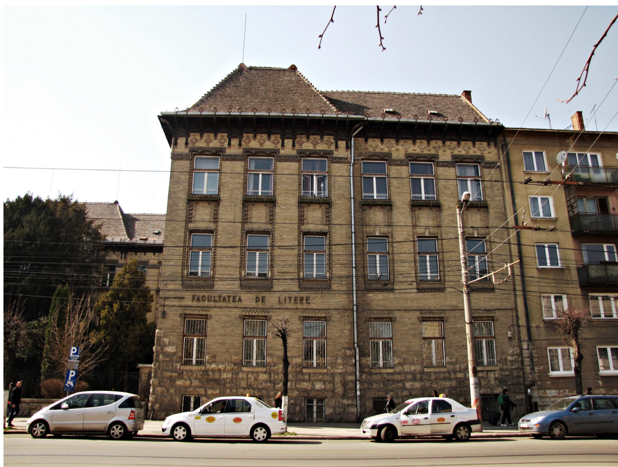
12. kép. Főhomlokzat, északi szárny (a szerző felvétele) Fig. 12. Main facade, northern wing (photograph by the author)
