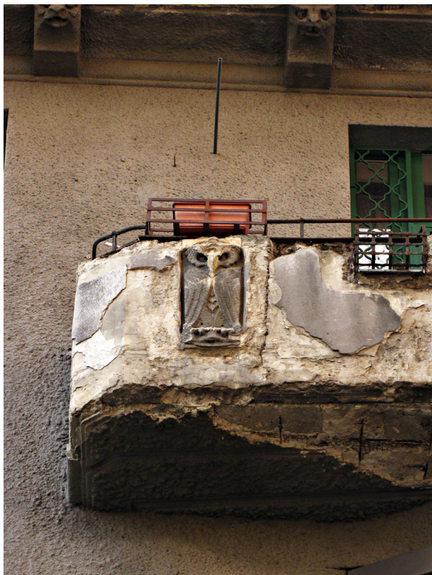
32. kép. Bérház, Üllői út 119. szám, Budapest, 1910 körül (a szerző felvétele) Fig. 32. Tenement house, 119 Üllői street, Budapest, built around 1910 (photograph by author)
