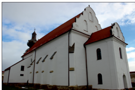
3. A templom jelenlegi összképe a felújítás után, északnyugati irányból
