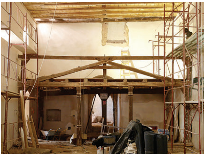
25. A torony hajó felőli fala az első emelet eredeti bejáratának visszafalazása után
