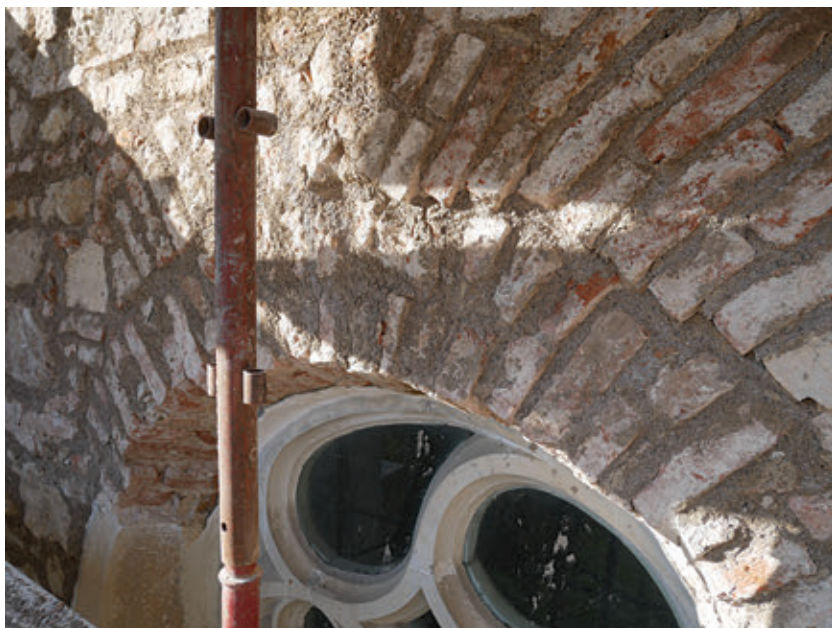
38. A déli homlokzat nyugati ablakának 1765 után újrarakott záradéka
