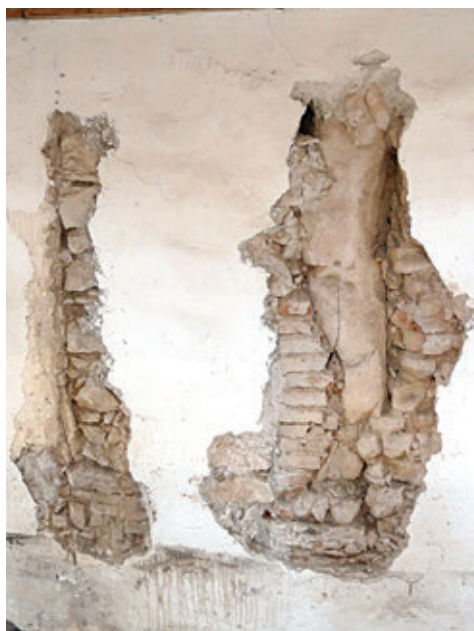
23. A torony hajdani első emeleti bejáratának elfalazott kökerete a kutatáskor
