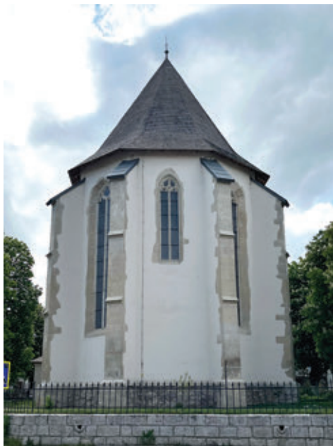
28. A szentély poligonális záradéka
