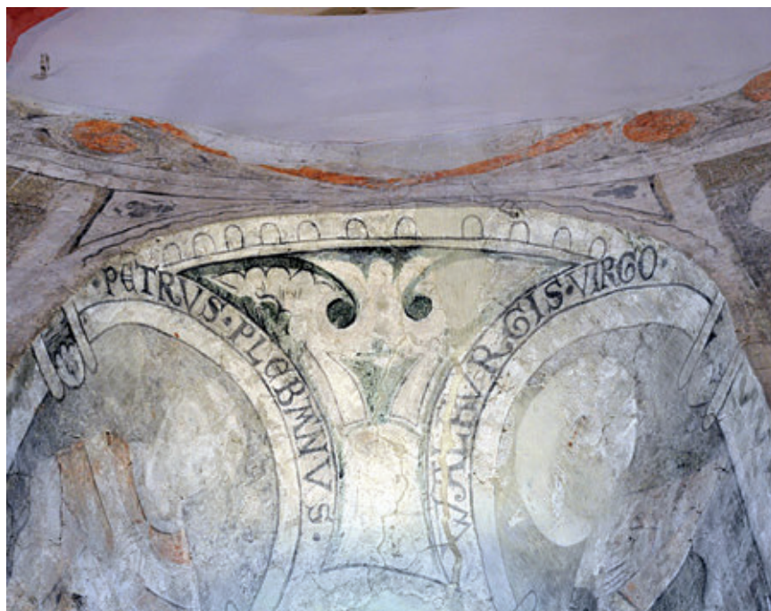
12. Nagdisznód, falképek a főapszis keleti ablakbélletében és az ablak fölött
